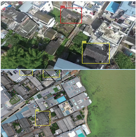
图 20 损坏建筑物检测
